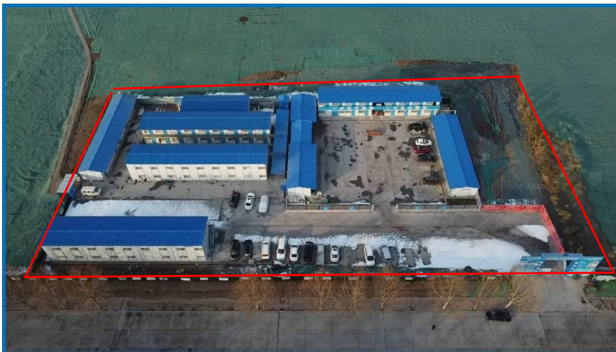
图1-3 施工生产生活区
