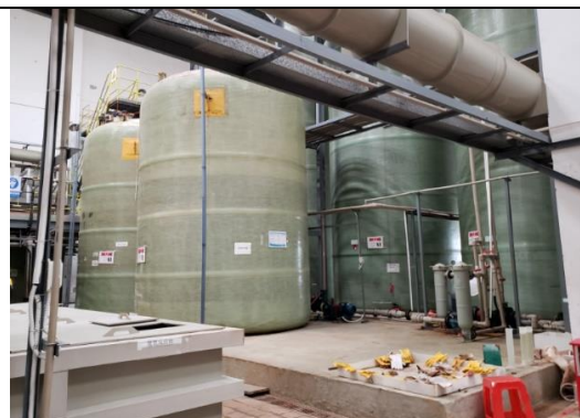
储罐区围堰
